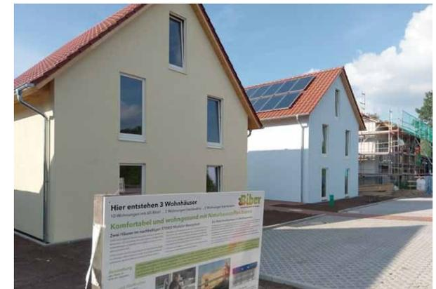
2 Mehrfamilienhäuser, Verden-Neumühlen: Neubau in Holzrahmenbauweise mit Cellulose-Dämmung (Bj. 2018). Special feature: Optimale CO<sub>2</sub>-Senke durch fast ausschließliche Nutzung von nachwachsenden Rohstoffen. (Bild: Uli Steinmeyer)
